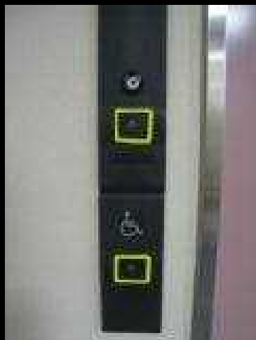
エレベーター ボタン
